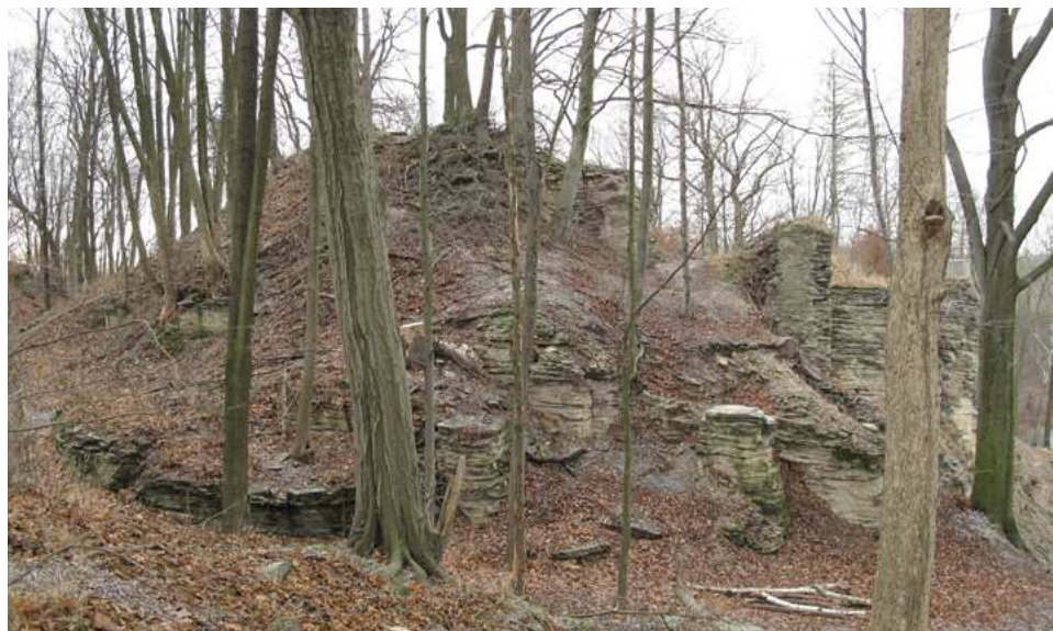
Obr. 2. Pohled od severovýchodu. Foto autor, 2014.
